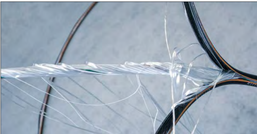
Kabelmantel 5.5 m absetzen
