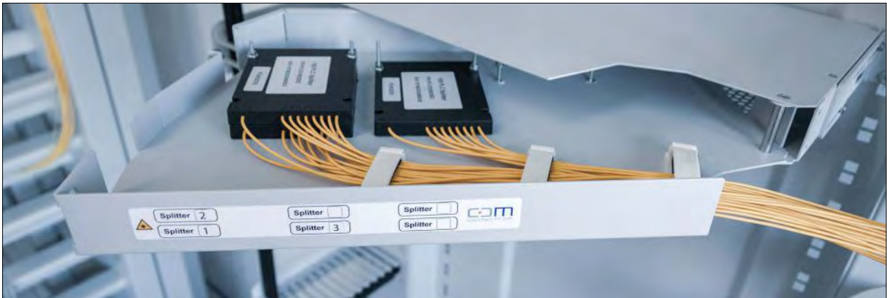
Einbau von max 6. PLC Splitter, max 198 Patchkabel (1.7 mm)
