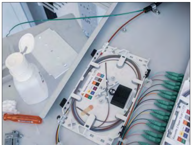
Bündeladern befestigen, absetzen und Fasern in Kassette legen
