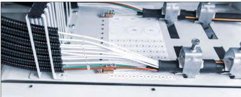
Nummerierung Bündeladern
