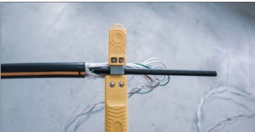
Zentralelement 10.5 cm absetzen
