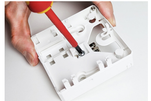
7B Hutschienenhalter an Dosenboden befestigen.
