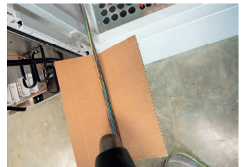
4F Bündelader mit Heissluft glätten und in den Wellschlauch einführen. Tipp: Zur Erzielung eines besseren Glättungsergebnisses, einen geknickten Karton unter den Bündeladern platzieren. Achtung! Bündeladern nicht zu heiss föhnen, um Beschädigungen zu vermeiden.
