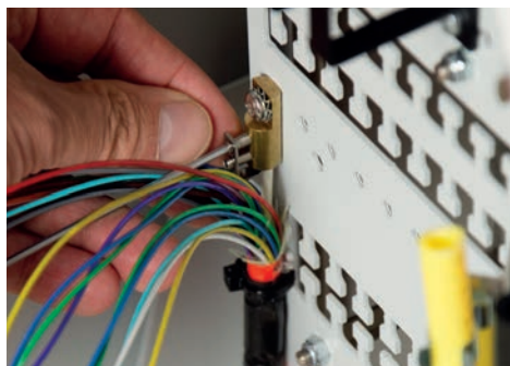
4E Abfangung auf Zentralelement stecken und anschliessend Abfangung auf Kabelabfangplatte befestigen. Madenschrauben anziehen. Tipp: Abfangung ausserhalb der Kabelachse setzen, so dass die Bündeladern daran vorbeilaufen. Werkzeug: PH1 Schraubendreher, Innensechskantschlüssel 2 mm
