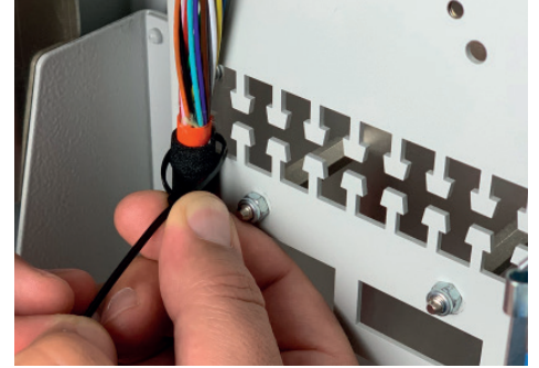
4C Kabel an Kabelabfangplatte mit Kabelbinder befestigen. Material: Kabelbinder
