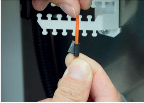
6F Kabel mit Vulkanband umwickeln. Material: Vulkanband (Art.Nr. 969441)
