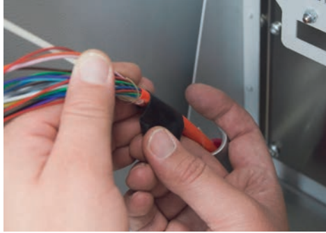
4B Abgesetztes Kabel mit Vulkanband umwickeln. Material: Vulkanband (Art.Nr. 969441)
