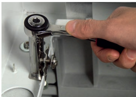
7B Erdungsklemme wird mittels mitgelieferter Mutter an dem dafür vorgesehenen Bolzen befestigt. Werkzeug: Steckschlüsseinsatz SW 13
