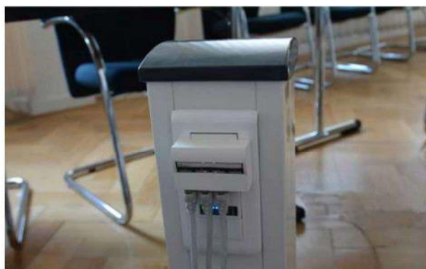
Kommunikationssäule mit Steckdosen
